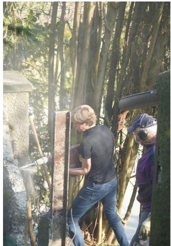
Frauen Power beim Abbruch.
