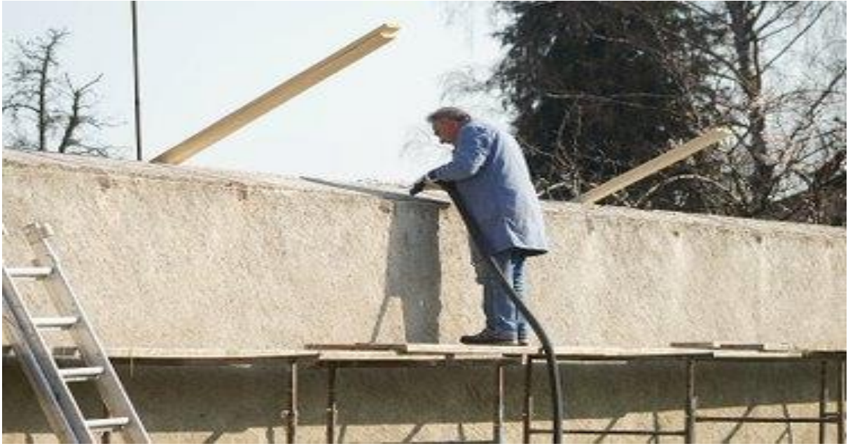
Reinigung der Mauerkrone
