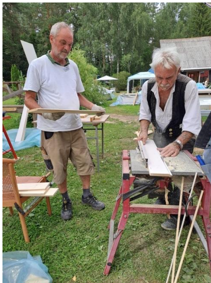
Roland und Ingo beim Zuschneiden der Paneele
