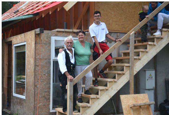
Ingo der Initiant der provisorischen Aussentreppe ist stolz auf die gelungene Sonntagsarbeit.
