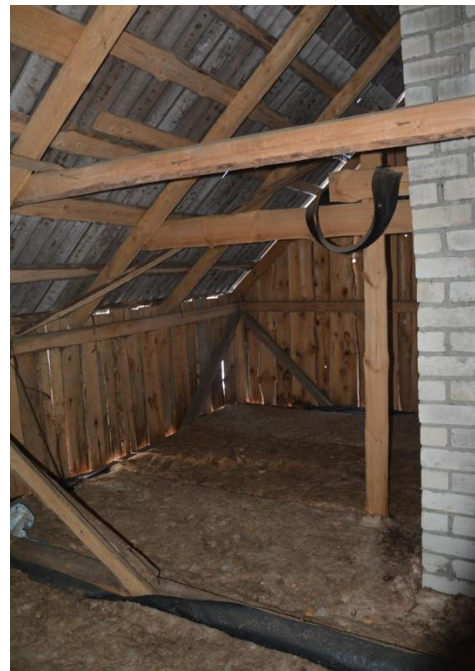
Dachboden der Scheune
