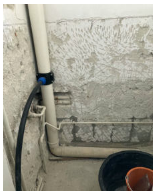
Nach dem Abbruch der Mauer zum WC.
