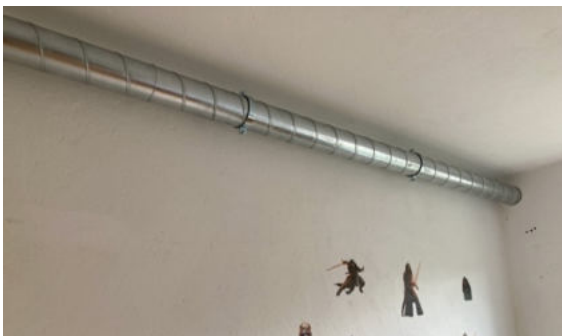
Montiertes Ventilationsrohr im Schlafzimmer der Jugendlichen.
