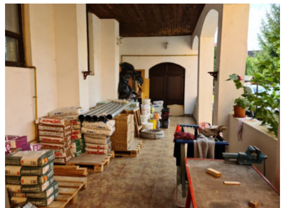
Eingerichtetes Materiallager unter dem Kirchenvordach.
