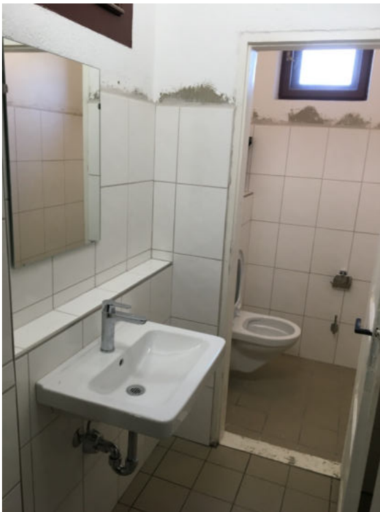
1. Obergeschoss: WC mit Lavabo rechts.
