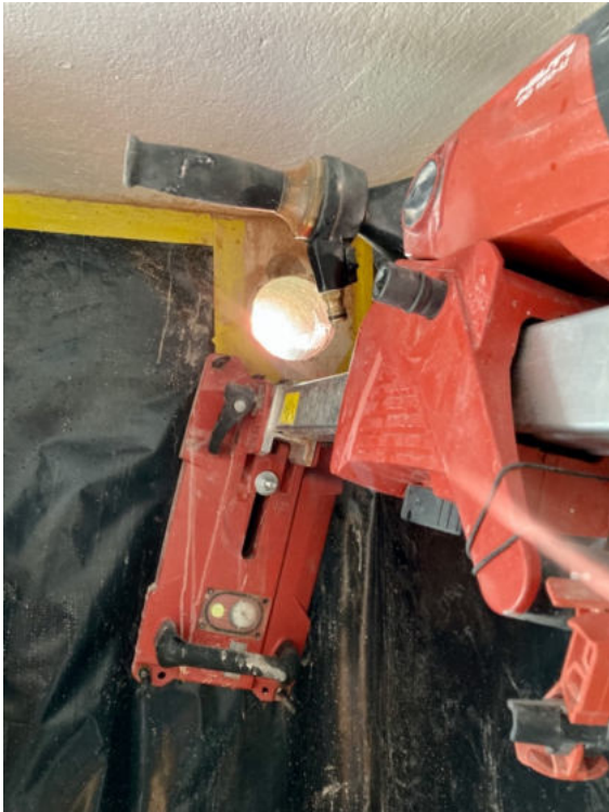
Fritz Schopper und Karl Frei beim Bohren mit der Diamantbohrmaschine.
