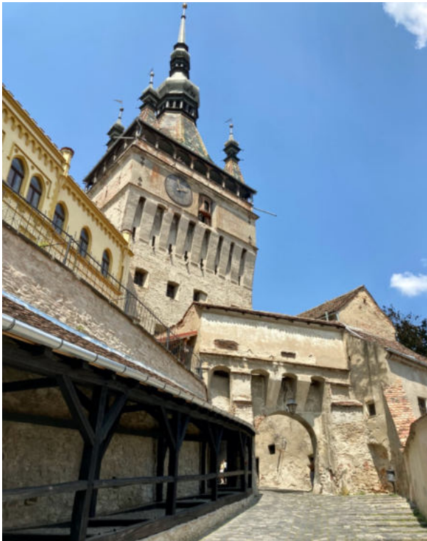
Stundturm von der Festungsanlage.
