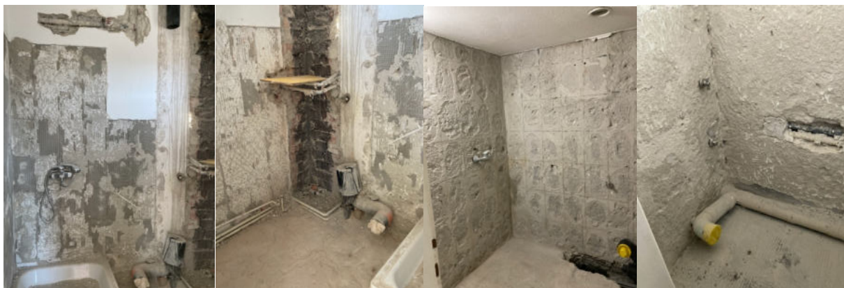
Der Vortrupp hat mit den rumänischen Jugendlichen des Kinderheims eine tolle Vorarbeit geleistet, so dass am Montag alle mit den verschiedenen Arbeiten beginnen konnten.
