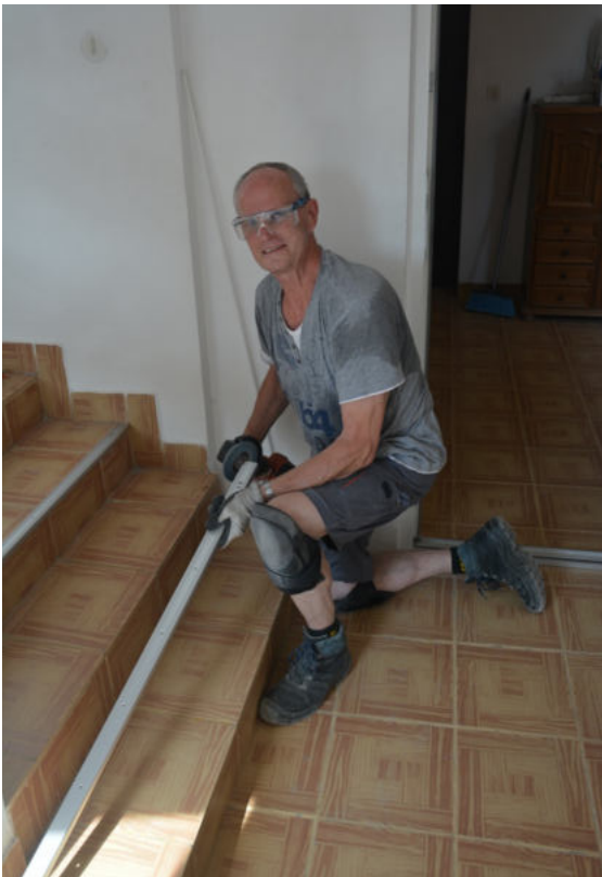
Fritz beim Verkleben des Stufenschutzes im ganzen Treppenhaus.
