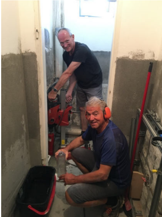
Fritz Schopper und Karl Frei beim Bohren mit der Diamantbohrmaschine.
