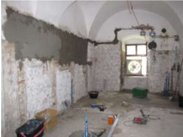
Der alte Verputz wird ausgebessert und Schlitz zugemauert.
