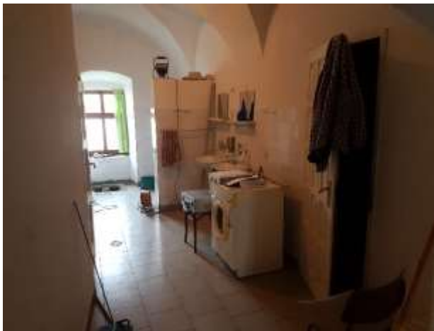
Dieser Teil wird zu einem zweckmässigen Dusch-, WC- und Waschaum umgebaut.
