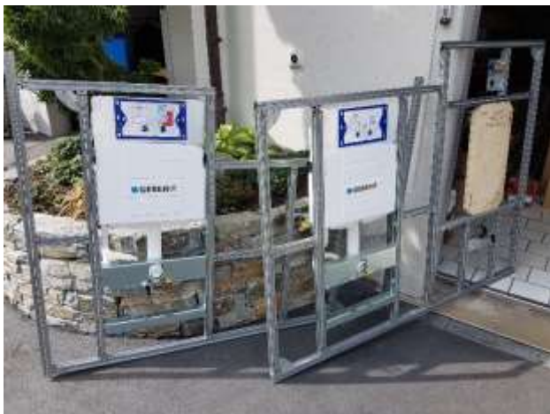
GIS-Rahmen mit UP-Spülkasten und Pissoir-Vorfabrikation sind zum Transport bereit.
