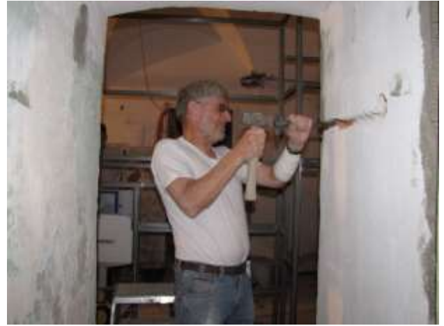
Die elektrischen Leitungen werden neu unter Putz verlegt.
