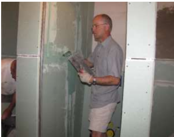
Stefan bei seiner Lieblingsbeschäftigung, - dem Ausfüllen der Fugen mit GEBERIT-Spachtelmasse
