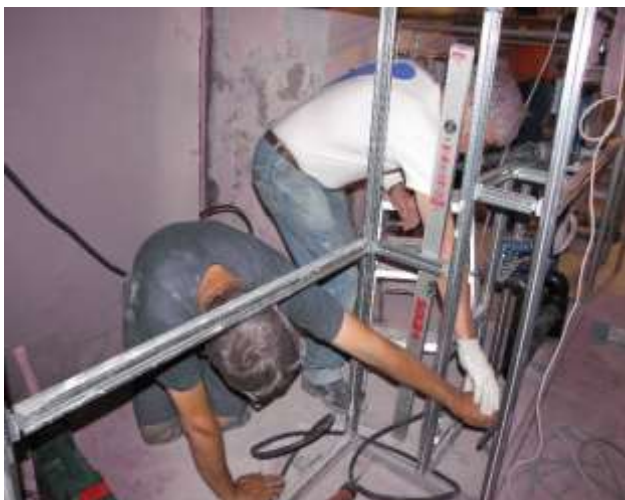
Auch die Schutzrohre für die elektrischen Kabel müssen in die Profilwände verlegt werden.
