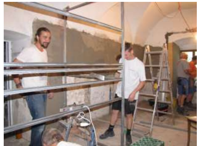
Schon entstehen die ersten Wände mit GIS-Profilen.
