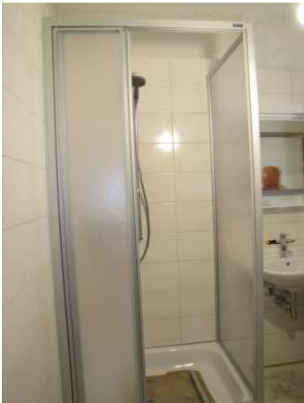
Nur noch die Garnituren müssen angebracht werden.
