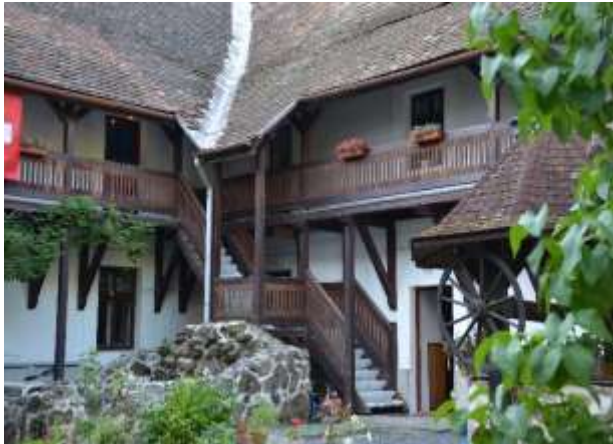
Hier sollen die Nassräume total renoviert werden.
