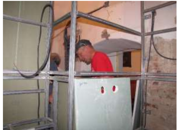
Thomas beim Beplanken der Wände.
