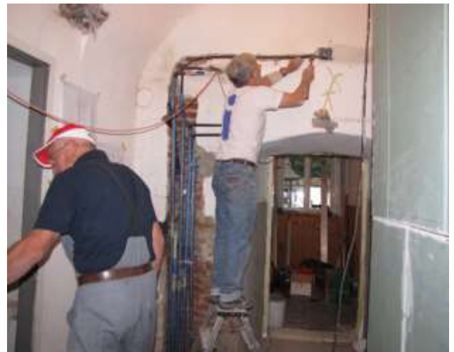
Der Zusammenschluss der Elektro-, Heizungs- Kalt- und Warmwasserleitungen an die bestehenden Installationen ist eine rechte Herausforderung.
