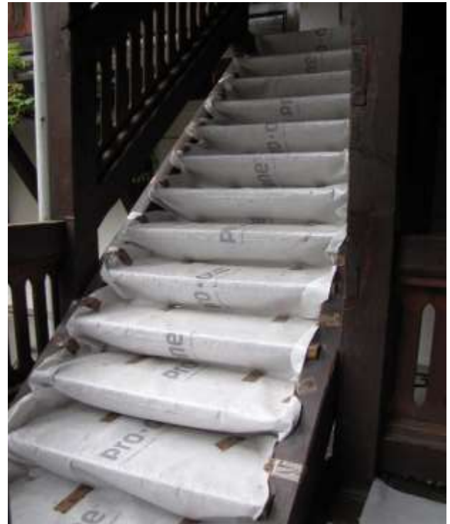
Zuerst werden alle „Gehwege“ im Haus sauber mit Floorliner abgedeckt.
