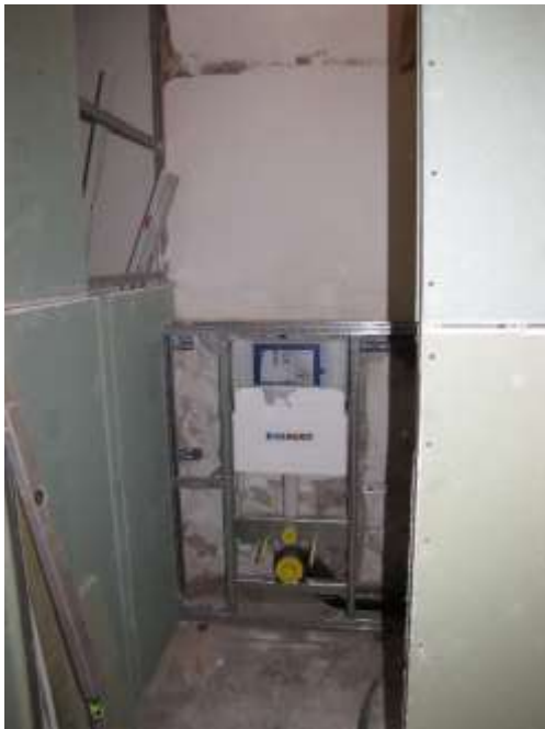
Das Beplanken der UP-WC's verlangt spezielle Anforderungen.
