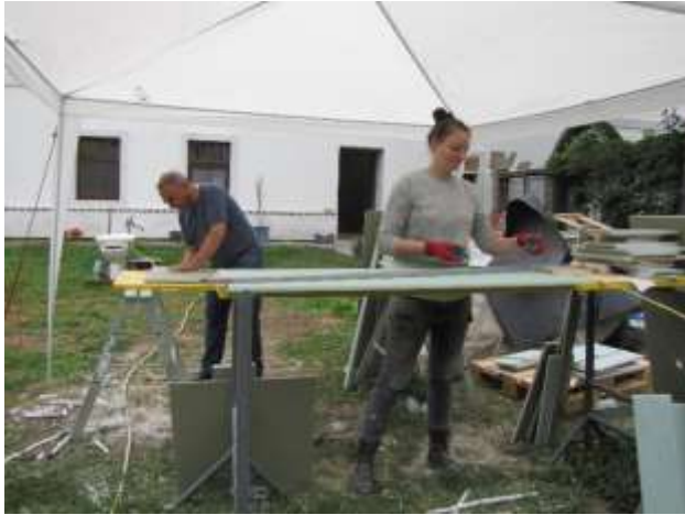
Kurt und Cornelia schneiden die GEBERIT-Gipsplatten unter dem Sonnendach perfekt auf das gewünschte Mass zu.
