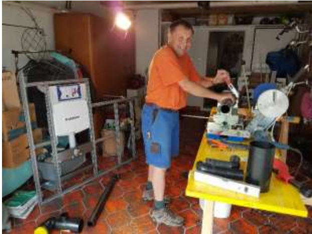
Franz Widmer beim Vorfabrikieren der Ablaufleitungen.
