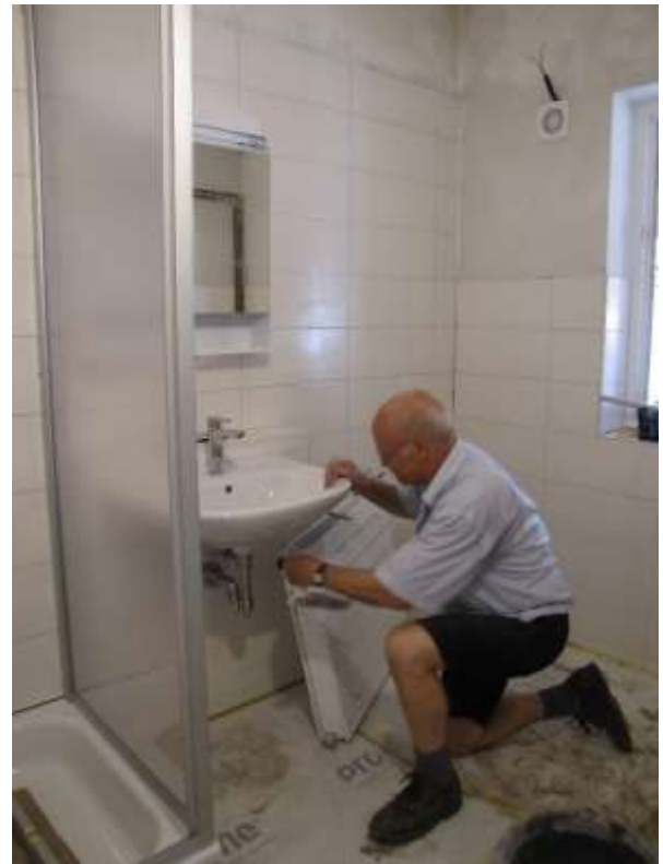
Gebi bei den Vorbereitungsarbeiten zum Montieren des Radiators.
