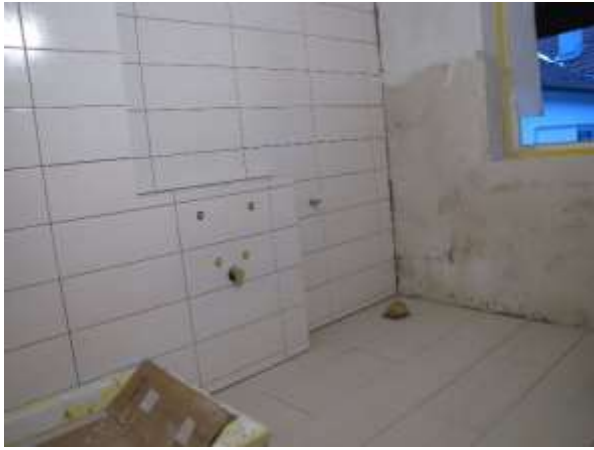
Die Duschwanne und die ersten Keramikplatten sind gesetzt.
