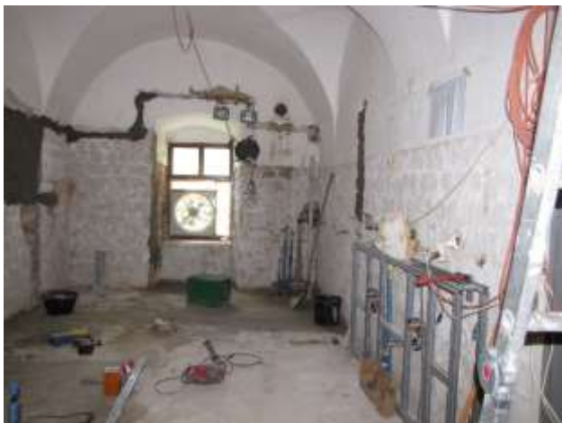
Die vorfabrizierten GIS.Rahmen für die zwei Waschtische werden montiert.
