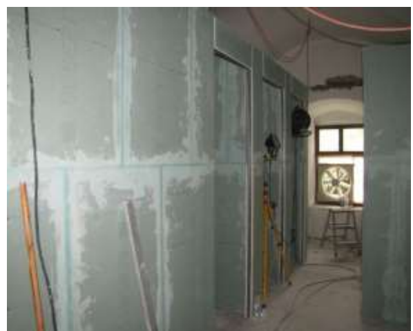
Die Wände sind bereit zum Verkleiden mit Keramikplatten oder für den Abrieb.
