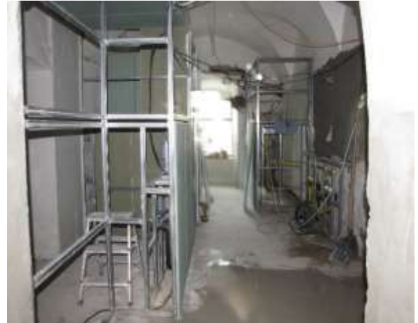
Die ersten Platten sind montiert und die Wände nehmen Gestalt an.
