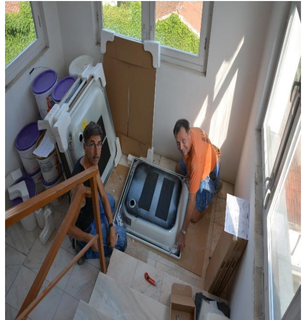
Duschwannen werden vorbereitet.
