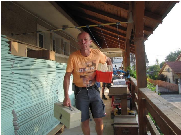
Thomas Leutenegger, Sanitärmeister, beginnt mit den Anschlüssen der Wasserleitungen.
