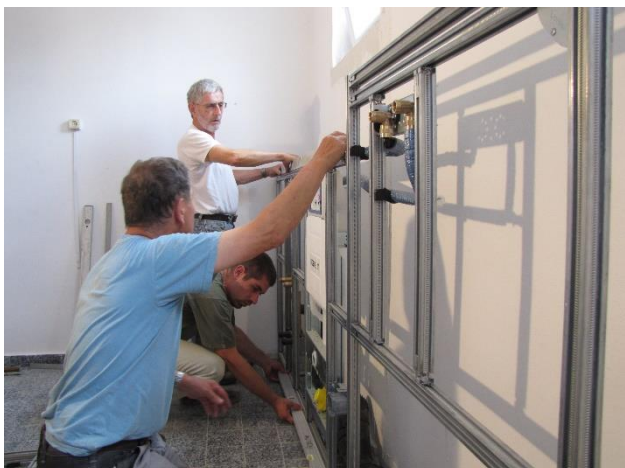
Die ersten GIS-Vorwände werden platziert.
