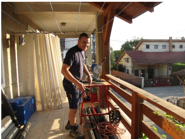
Cyrill Hof, Sanitärmeister, richtet sich für die Ablaufmontage ein.
