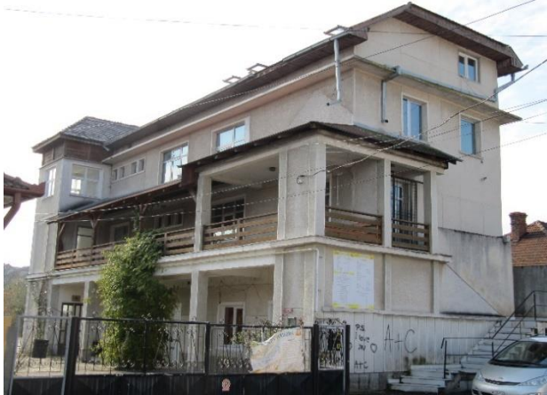
Hier sollen die Nassräume total renoviert werden.
