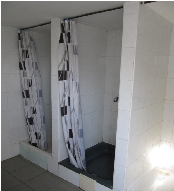
Noch ohne Duschtrennwände und Umkleide.
