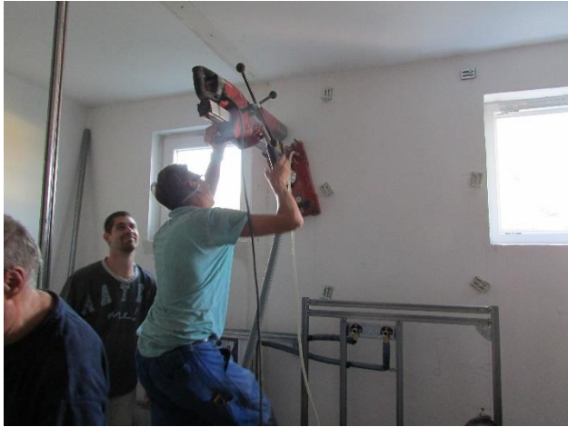
Wanddurchbruch bohren für Ventilator.
