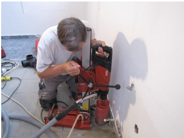
Mit der Diamant-Bohrmaschine werden Bohr- löcher bis 130 mm in Decken und Wänden gebohrt.
