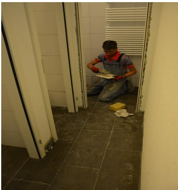
Türfutter montiert und Boden fast fertig.
