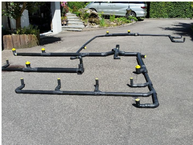
Einzelne vorgefertigte Ablaufleitungen mit Geberit Silent.
