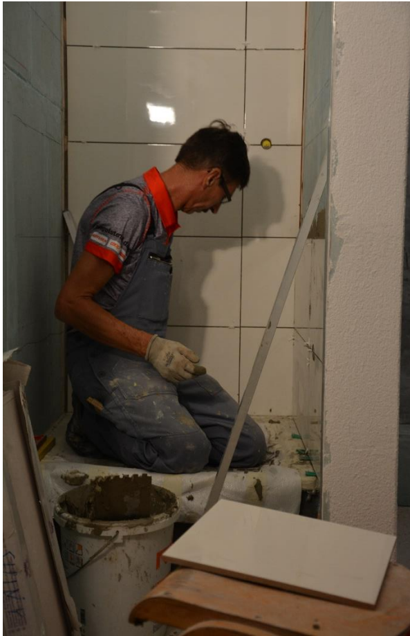
Plättliarbeiten in der engen Dusche
