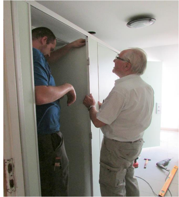
Anpassung der Kabinenwände.
