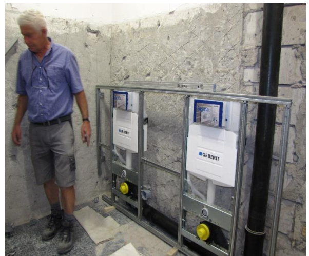
Vorfabrizierte GIS-Profile mit Geberit UP-Spülkästen werden zuerst montiert.
