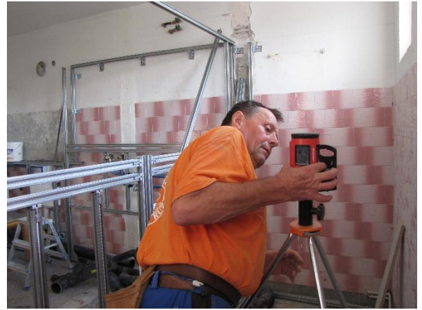
Mit dem Nivelliergerät stimmen alle Masse.
