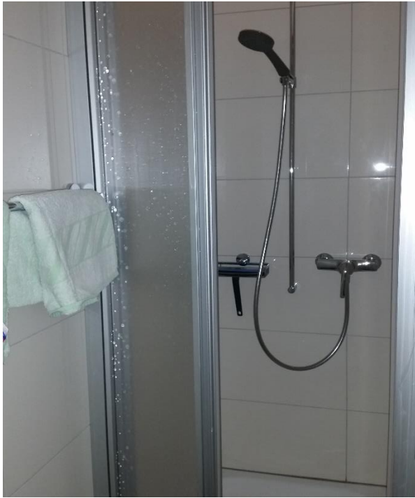
Total wurden 6 Duschenräume mit Trennwand..
