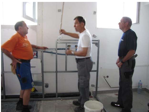
Franz Widmer, Spengler-Sanitärinstallateur und Allrounder Othmar Ankli werden durch Edi Rüttsche für ihre Aufgaben instruiert.
