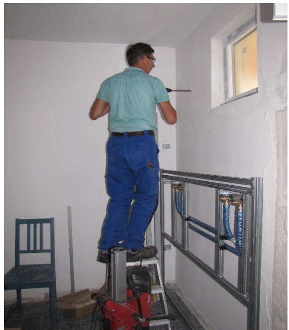
Sanitärmeister Willi Bollhalder beginnt mit den Wanddurchbrüchen für die Ventilatoren.
