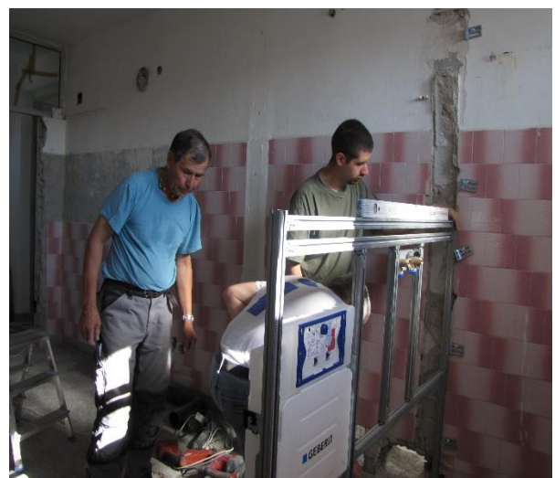
Die ersten vorfabrizierten freistehenden GIS- Wände müssen genau ausgerichtet sein, damit die folgenden Trennwände für die Duschen stimmen.
