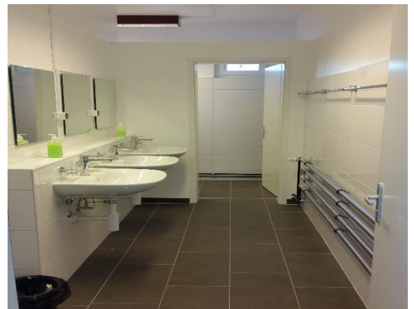
4 Ventilatoren und 7 Waschtische eingebaut.
