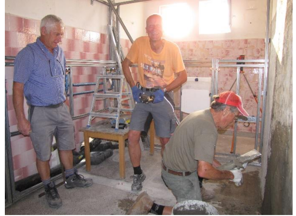
Alte Wände werden verputzt und Thomas schliesst die Wasserleitungen an.
