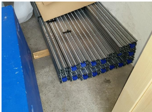
Die 5m langen GIS-Profile ergeben das Gerüst für die neuen Trennwände der Badezimmer.
