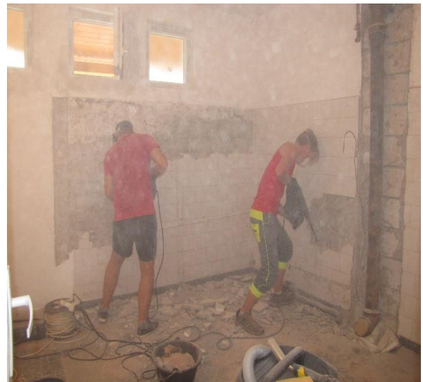
Beim Abspitzen der alten Plättli entsteht ein riesiger Staub
