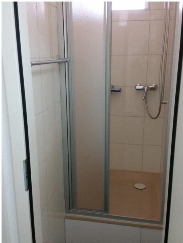
Im 1. OG sind nun je zwei Duschen, WC-Anlagen und Waschtische fertig eingebaut. Auch der Heizungs radiator und der Ventilator funktionieren einwandfrei.
