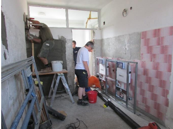
Mauern wurden abgebrochen und neue Türen und Wände eingesetzt.
