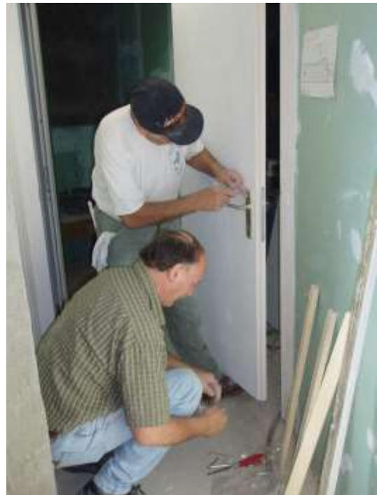
Ernst und Charlie montieren bereits die neuen Türen und die Beschläge.
