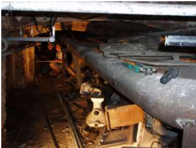
In den "Katakomben", der Unterwelt des Gebäudes müssen die Zuleitungen total neu erstellt werden.
