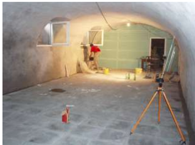
Die Wände und die Decke sind neu verputzt, der Boden von 20 x 5 m mit Gartenplatten belegt. Die Malerarbeiten und die elektrischen Installationen werden später durch die rumänischen Jugendlichen ausgeführt.
