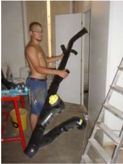
Vorfabrizierter Geberit-Ablauf für beide Duschräume.
