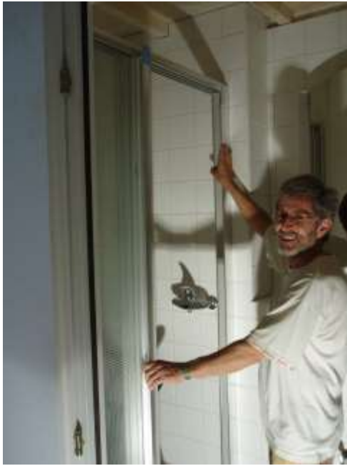
Montage der Duschtrennwände
