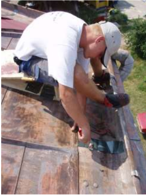
Reparieren von gerissenen Nähten
