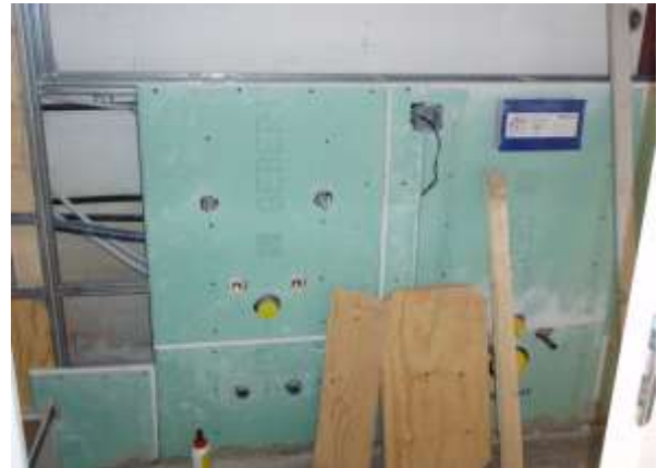
Jetzt ist der Spülkasten versorgt.
