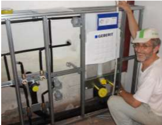
Der GIS-Rahmen mit UP-Spülkasten, Wasser- und Ableitungen ist gesetzt.
