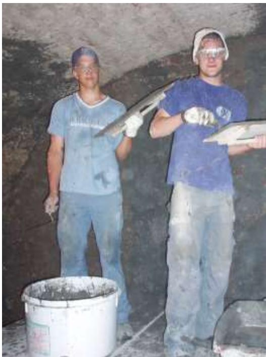
Strenge Verputzarbeiten am Deckengewölbe.
