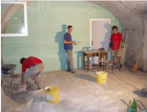
Eine Trennwand zur Unterteilung des Kellers mit Geberit Duofix – System
