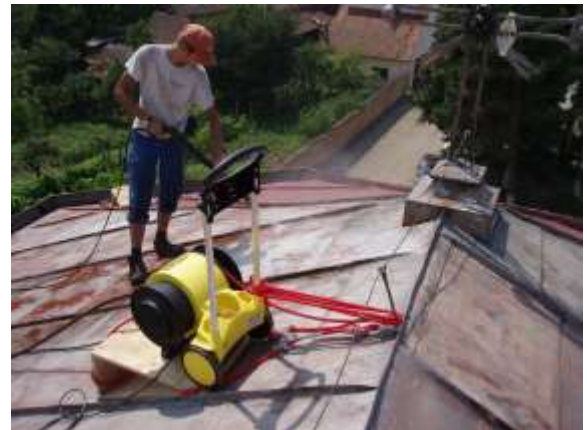
Hochdruck – Reinigung nach dem Schleifen
