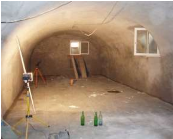
Die Wände und die Decke sind neu verputzt, der Boden von 20 x 5 m mit Gartenplatten belegt. Die Malerarbeiten und die elektrischen Installationen werden später durch die rumänischen Jugendlichen ausgeführt.
